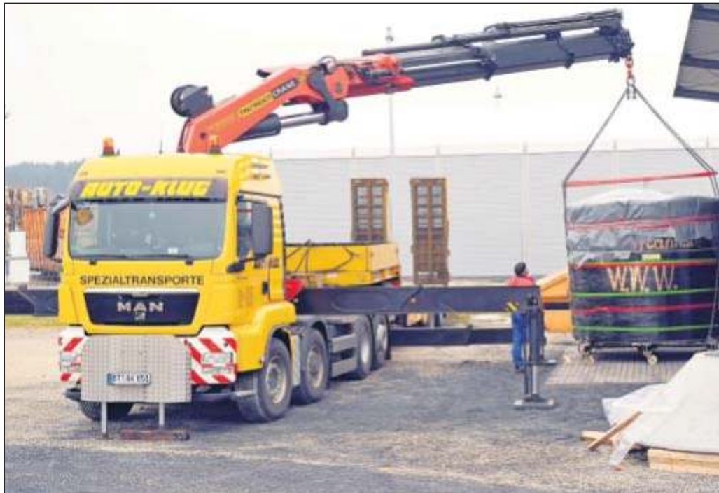
Der Wärmespeicher geht auf die Reise.
